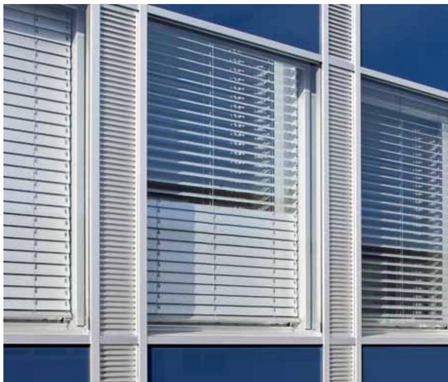
Aluflex® Reflect con diverse posizione di lamelle in un telo (opzione).
